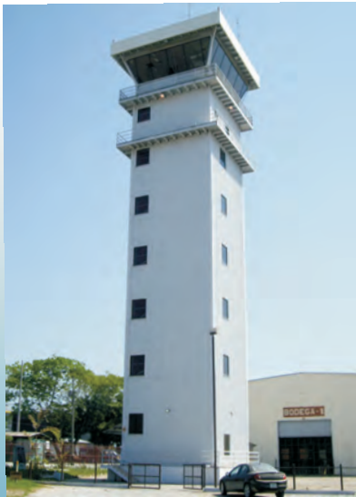
TORRE DE CONTROL DE OPERACIONES PORTUARIAS DE LA ENP-HONDURAS DONDE SE ALBERGA EL SISTEMA DE MONITOREO DE BUQUES Y BOYAS
